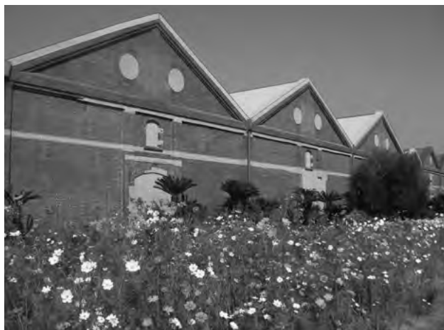
大里製粉所時代からの倉庫。現在はニッカウヰスキー門司工場(旧・大里酒精製造所)が使用
