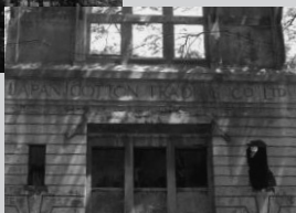
戦前まで使われていたボンベイのコットンハウス。インド奥地で買い付けた綿花をえり分けたり計量したりした自社専用倉庫ビル。石造りのビルの正面壁面にはJAPAN COTTON TRADING CO LTD(日本綿花株式会社)の名が刻まれていた(すでに取り壊されている)。
