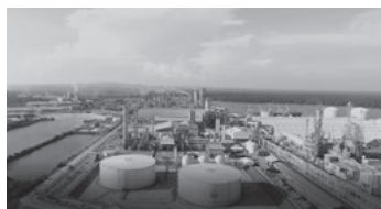
インドネシアKMI社のメタノール製造プラント
