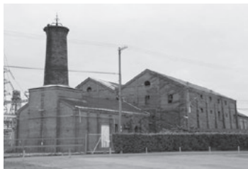
創業期に建設された石炭ボイラー(ダイセル網干工場)
