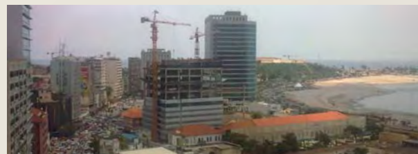
ビル建設の槌音が響く首都ルアンダ
