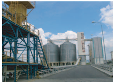
IFV社の製粉工場、サイロ、穀物エレベーターと荷役コンベヤー
