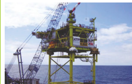
トールズガス田のプラットフォーム
