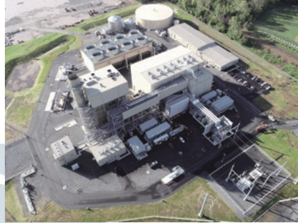
バースボロー発電所
