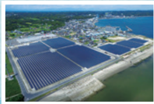
知多美浜太陽光発電所
