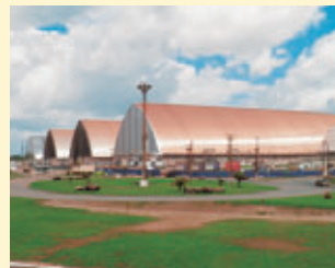
ブラジル穀物事業の輸出拠点 北部イタキ港の穀物保管倉庫
