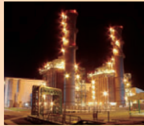
①ベトナム フォーミー 3火力発電所
