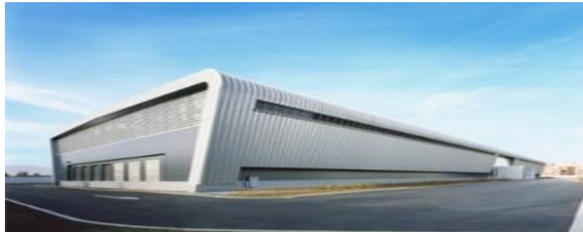
石狩データセンター
