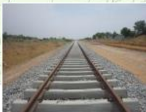
インド 鉄道敷設・電化工事
