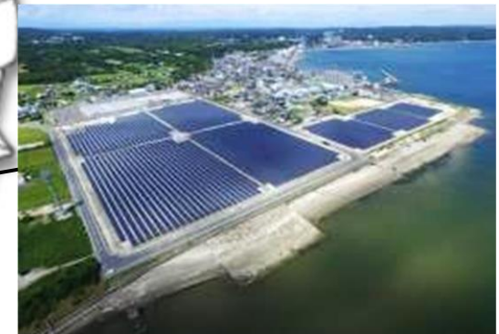
愛知県知多美浜町 (13MW)
