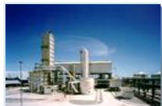
メタノールプラント
