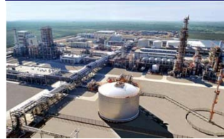
プラントプラント外部
