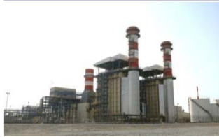
電力プラント外部
