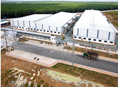
ベトナム ロテコ工業団地
