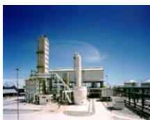
メタノールプラント
