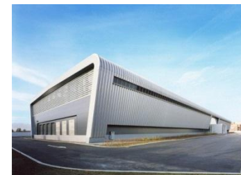
データセンター/クラウド
