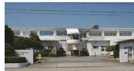
写真: 三重工場外観
