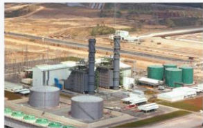
フーミー3発電所
