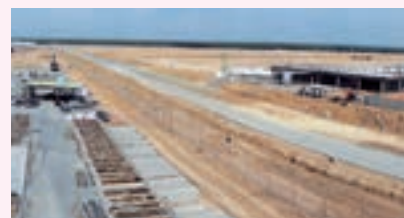
ロンドウック工業団地の建設作業
