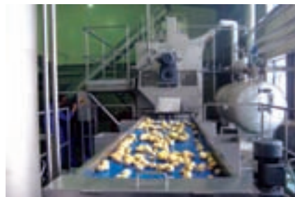
中国黒龍江省に建設したポテトフレーク製造工場
