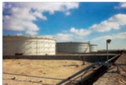
エジプトの油田に併設するタンク
