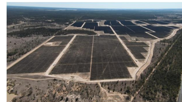
完成写真（2023年9月）
