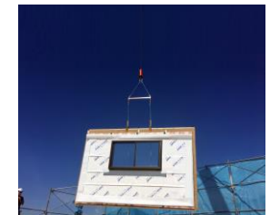
木材大型パネル (あからじめ工場で柱や梁等を一体化したパネル)
