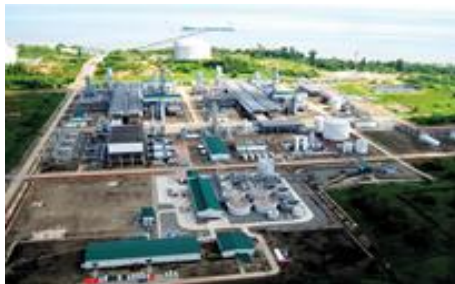
Indonesia/Tangguh LNG terminal
